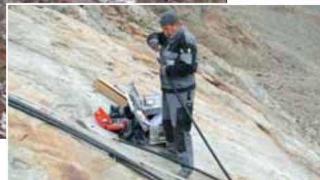
Stubaier Gletscher: Arbeiten von ELEKTRO BERCHTOLD an Hochspannungs-Muffen im schwierigen Gelände
